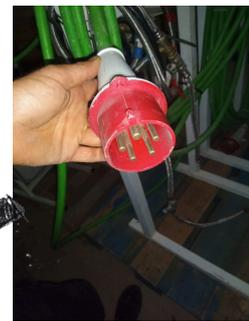
Chauffe-eau : 400v 24 kw. Entrée triphasée.
